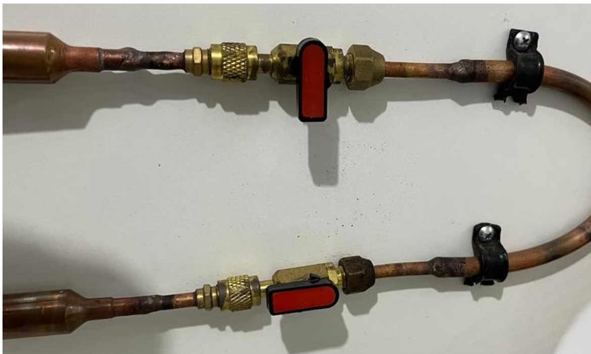
Figura 18 - Válvulas Agulhas Instaladas Fonte: Autoria Própria
