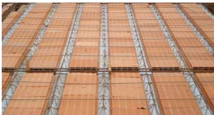
Figura 4 - Laje treliçada com blocos de cerâmica
