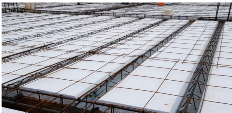
Figura 3 - Laje treliçada com blocos de EPS Fonte: https://www.lajesconceicao.com.br/lajetrelicada
