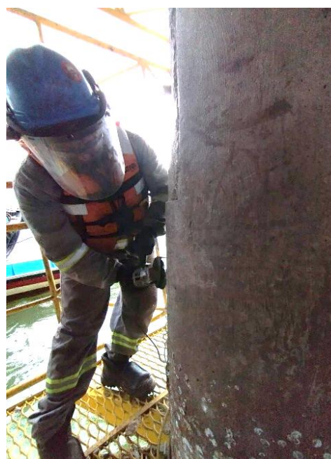
Figura 12: Desbaste controlado da região afetada, sulcos. Fonte: O autor, 2025.
