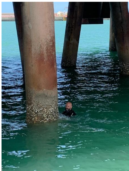
Figura 8: Mergulhador realizando o processo de limpeza da estrutura. Fonte: O autor, 2025.
