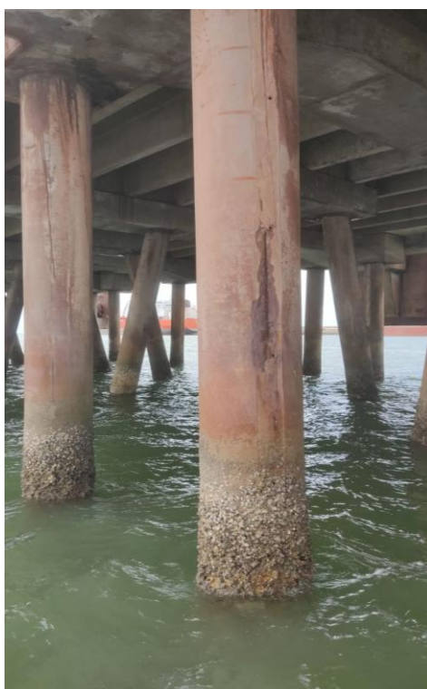
Figura 6: Deslocamento da camada de cobrimento com cordoalha exposta. Fonte: O autor, 2025.
