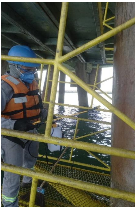
Figura 17: Aplicação do impermeabilizante. Fonte: O autor, 2025.
