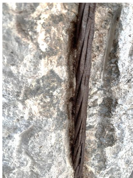
Figura 14: Armadura ativa oxidada. Fonte: O autor, 2025.
