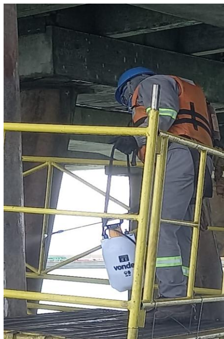
Figura 18: Aplicação do impermeabilizante. Fonte: O autor, 2025
