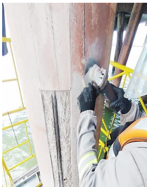
Figura 13: Armadura ativa após a limpeza. Fonte: O autor, 2025.
