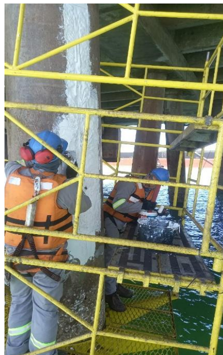
Figura 16: Recomposição da camada de recobrimento finalizada. Fonte: O autor, 2025.
