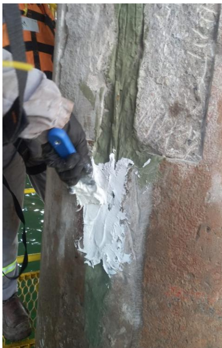
Figura 15: Recomposição da camada de recobrimento. Fonte: O autor, 2025.
