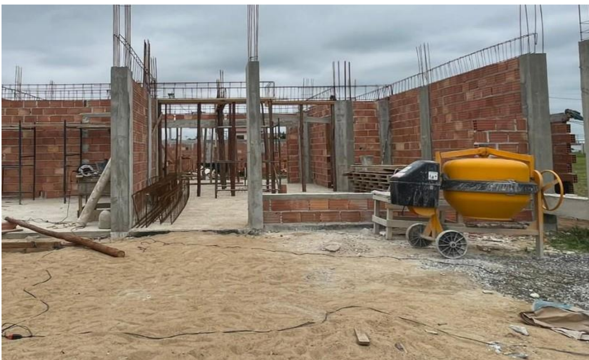
Figura 9: Imagem da frente do canteiro real na fase de locação das vigas do primeiro pavimento. Fonte: Autor (2023)
