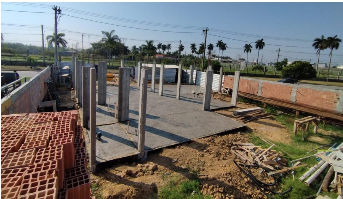
Figura 5: Imagem dos fundos do canteiro real na fase de concretagem do piso térreo. Fonte: Autor (2023)
