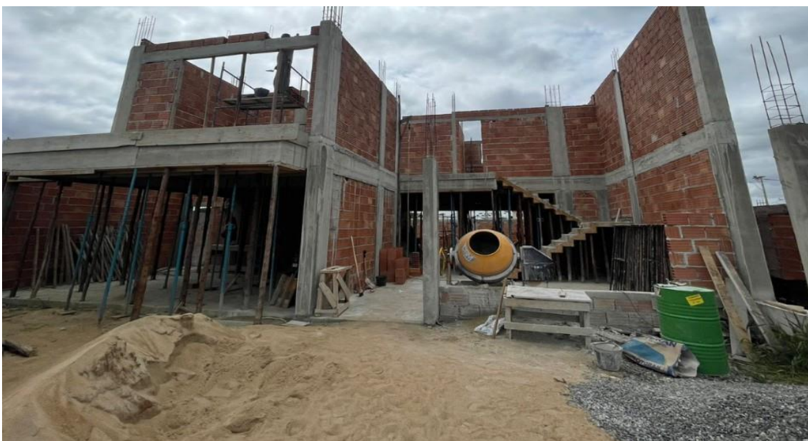
Figura 10: Imagem da frente do canteiro real na fase de finalização do entijolamento do segundo pavimento. Fonte: Autor (2023)
